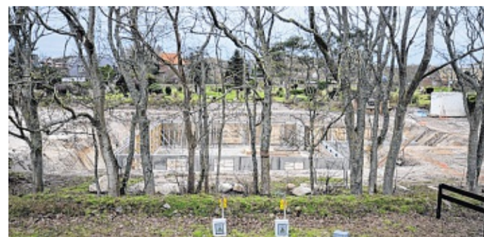
Die Wände des Kellergeschosses stehen bereits.
